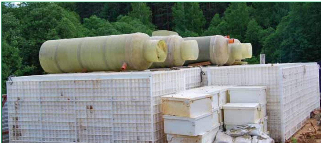
Московская область. Коттеджный поселок (100 м³/сут.) Установка очистки ливневых стоков «ЮНИЛОС» (10/30 л/с)
